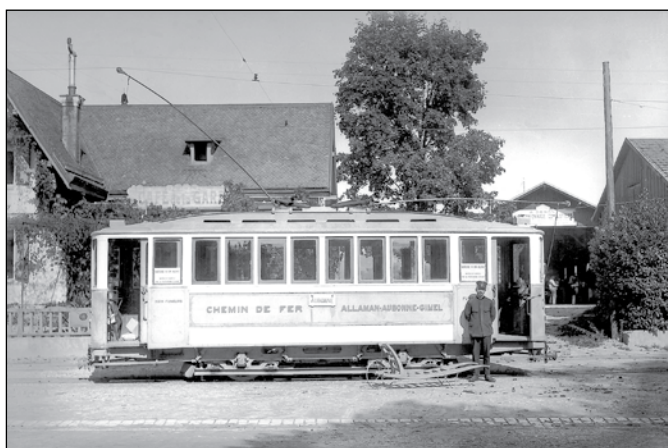
Allaman (AAG): A la suite de sa transformation intégrale durant les années 1920, la Ce 2/2 1 se présente comme neuve. L'image a été prise vers 1927 devant le buffet de la gare d'Allaman. Photo extraite de Tram n° 83, page 36. Prise de vue: archives Musée suisse des transports, collection Markus Schweyckart
